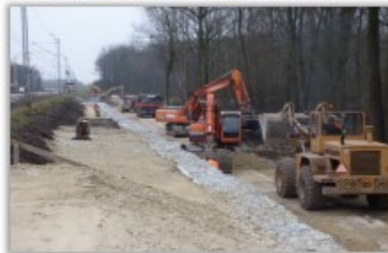
Nowoczesne metody stabilizacji nasypów kolejowych Likwidacja ograniczenia w pobliżu przystanku osobowego Lipki na odcinku Opole-Wrocław
