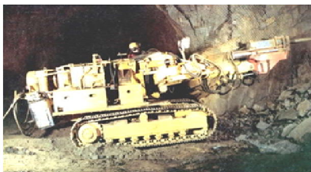
Rys. 5. Widok kombajnu chodnikowego na podwoziu gąsienicowym firmy Salzgitler typ SK-HR, z zabudowanym na ramieniu hydraulicznym młotem udarowym podczas urabiania przodka chodnikowego [13]
