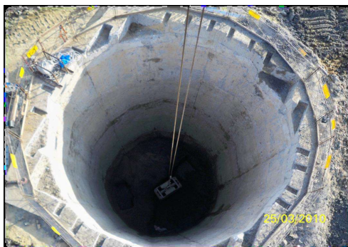
Rys. 5. Budowa „ścianki szczelinowej”[2]
