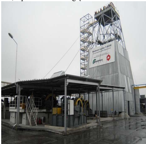
Rys.4 .Widok wieży tymczasowej do głębinienia szybu[2]
