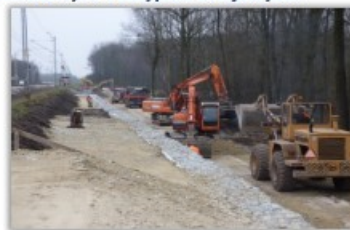
Nowoczesne metody stabilizacji nasypów kolejowych Likwidacja ograniczenia w pobliżu przystanku osobowego Lipki na odcinku Opole-Wrocław
