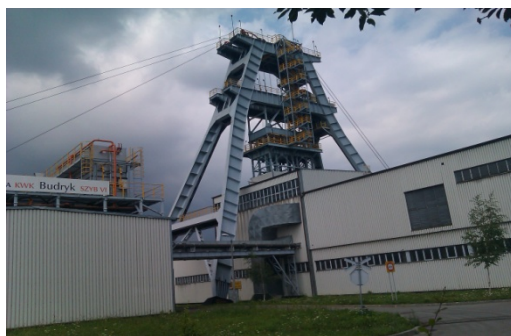
Rys.1. Widok wieży wyciągowej szybu VI adaptowanej do celów pogłębiania szybu [1]
