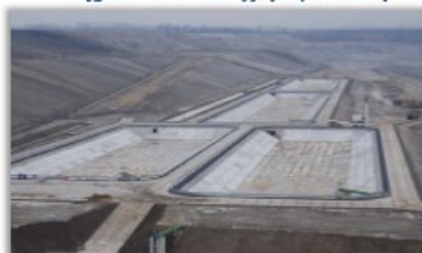
5 zbiorników retencyjno-osadowych i laguna w ramach systemu odwadniania odkrywki w PGE GiEK S.A. Oddział KWB Turów
