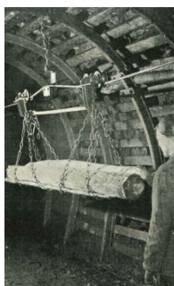
Rys. 1. Podwieszona kolej linowa [9]
